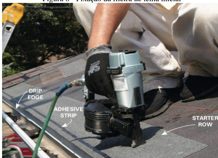
Figura 6 - Fixação da fileira de telha inicial
