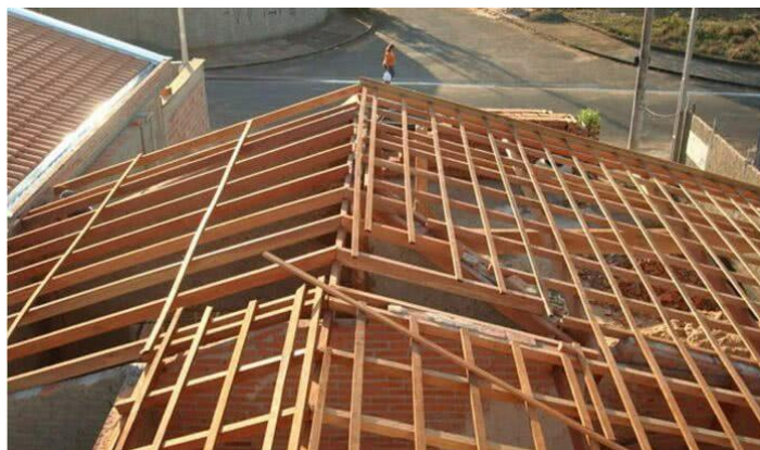
Figura 3 - Estrutura de cobertura tipo cavaletes e caibros
