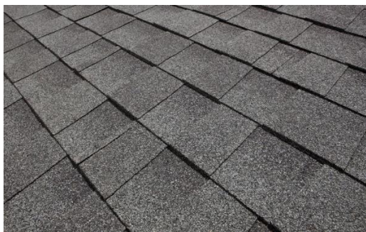
Figura 2 - Telhado shingle finalizado
