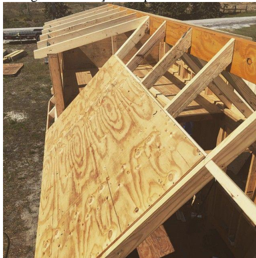
Figura 4 - Fixação dos painéis de madeira
