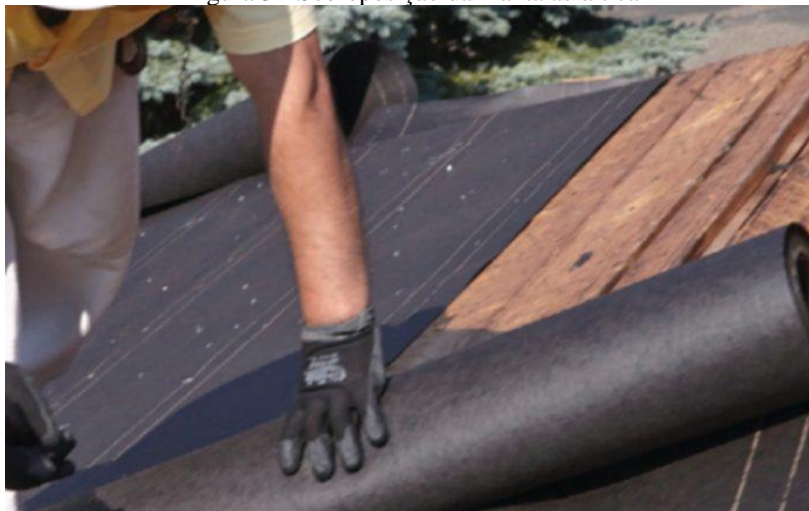
Figura 5 - Sobreposição da manta asfáltica
