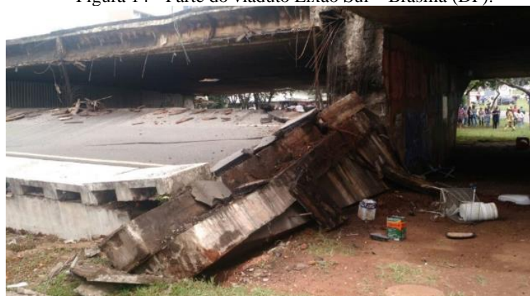
Figura 14 - Parte do viaduto Eixão Sul – Brasília (DF).
