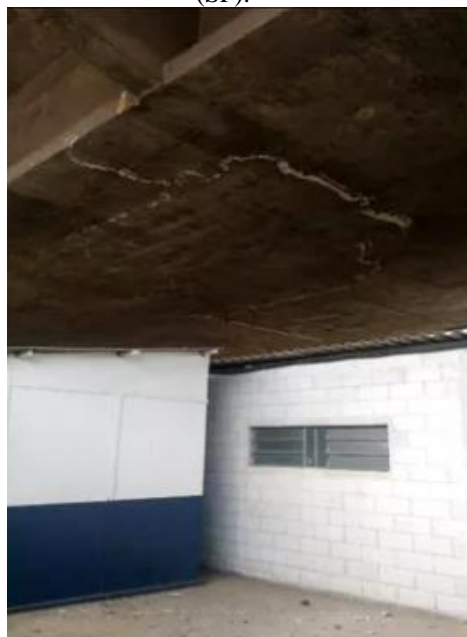
Figura 10 – Fissuras encontradas próximo ao ponto que cedeu no viaduto da Marginal Pinheiros, em São Paulo (SP).
