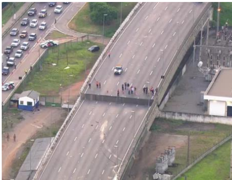
Figura 8 – Imagem aérea do colapso do viaduto da Marginal Pinheiros, em São Paulo (SP).
