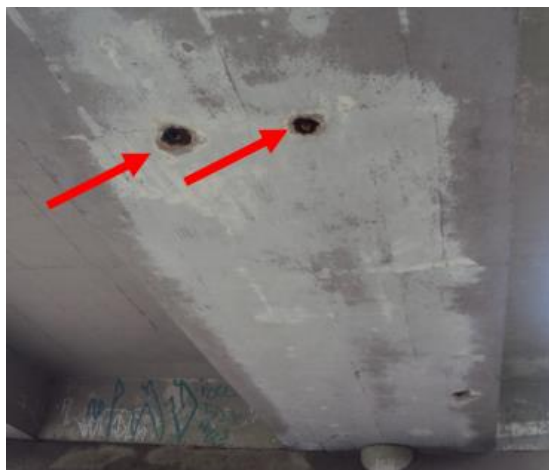
Figura 4 – Drenos danificados.
