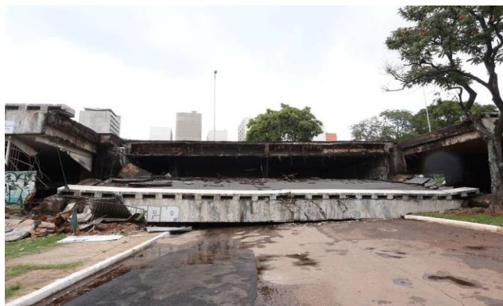
Figura 15 - Viaduto do Eixão Sul ao chão em Brasília (DF).
